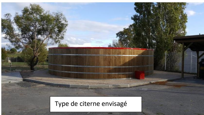
Modèle de citerne de 60 mètres cube, 2 m de haut, 6.5 m de diamètre, armature en bois maintenue par un cerclage métallique. Une bâche recouvre la citerne. Des contacts et des devis ont été reçus de la part d'entreprises proposant la mise en place de citernes de 60 mètres cube. Notre choix s'est arrêté sur ce type de citerne.
