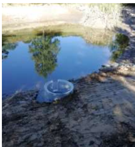
Mise en place de la buse
