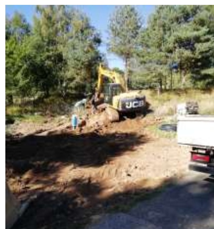
Percement de la digue et mise en place du poteau d'incendie
