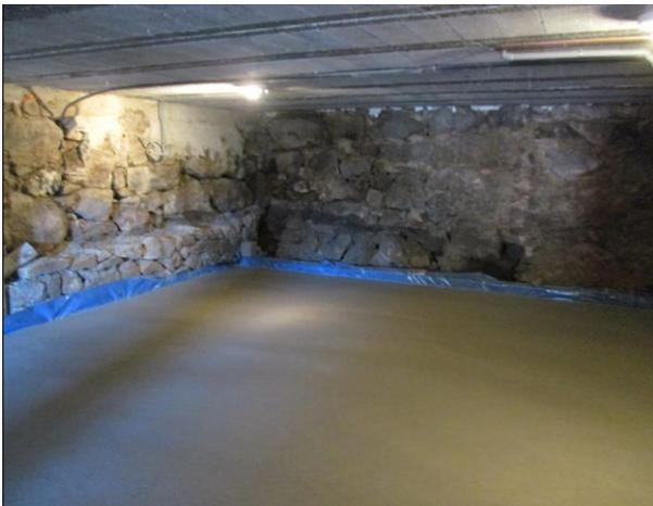
Des travaux de décaissage, drainage, réalisation d'une dalle en béton armé, aménagement intérieur...ont été réalisés pour agrandir ce local. Cet agrandissement est nécessaire pour le stockage des matériels et engin communal (déneigeuse) ou associatif. L'entreprise Girodet de la Ciove a été retenue pour ces travaux de maçonnerie. Un galandage sera prochainement réalisé en périphérie.
