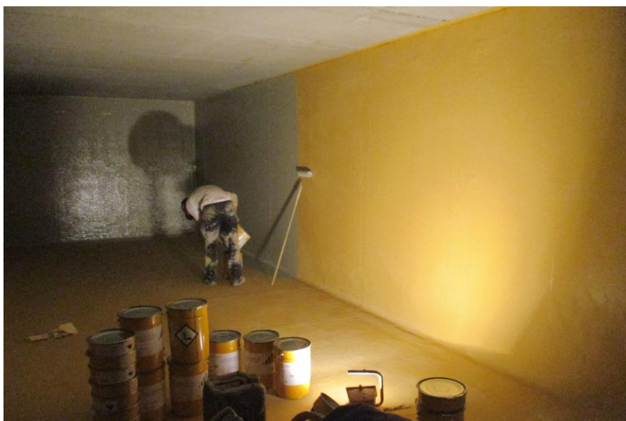
La pose de la couche d'étanchéité à l'intérieur de l'ouvrage
